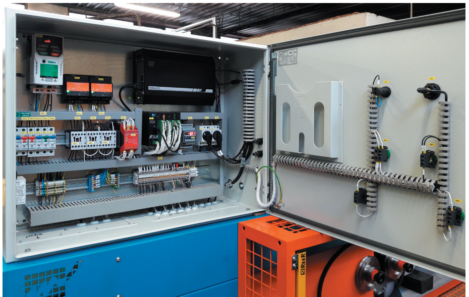
Obr 6: Rozvaděč je pevnou součástí stroje.
