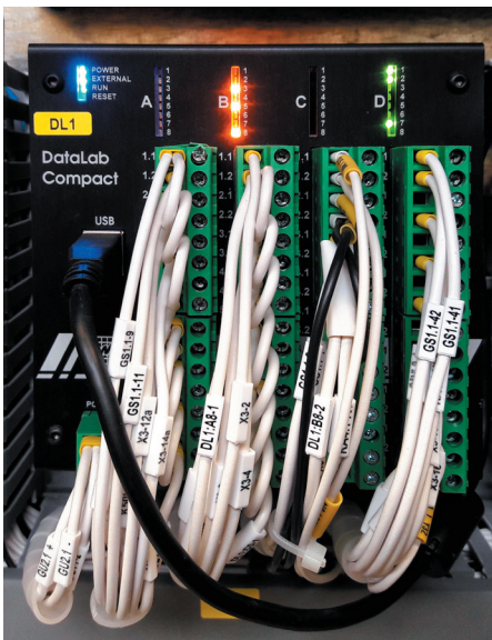
Obr 5: Jednotka DataLab Compact zabere jen málo prostoru.
